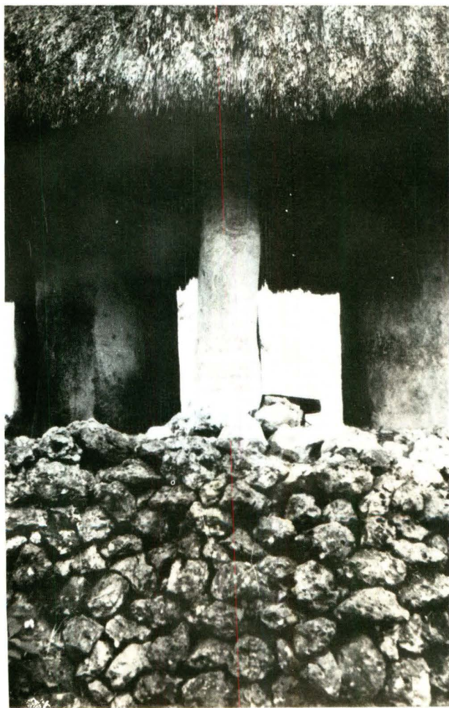
Tiang-tiang batu rumah marapu Lai Tarung. Pangkal tiang-tiang ditanamkan dalam tanah tanpa fondasi hanya "diurug" dengan tumpukan batu-batuan.
