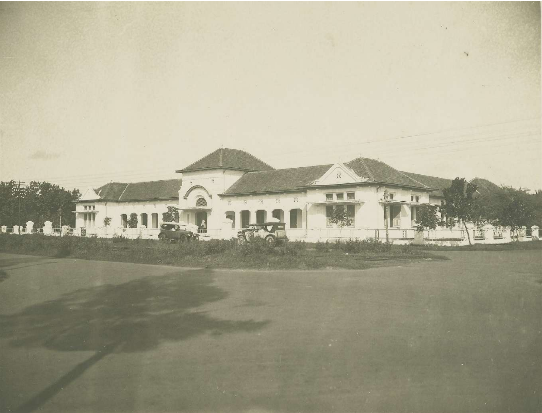
Gambar 2.7 Gedung Landraad dan Residentiegerecht di Surabaya, Tahun 1922. Sumber: Perpustakaan Universitas Leiden
