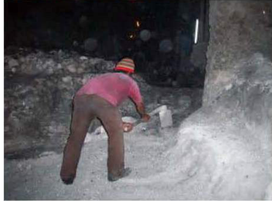
Lantai dibersihkan terlebih dahulu
