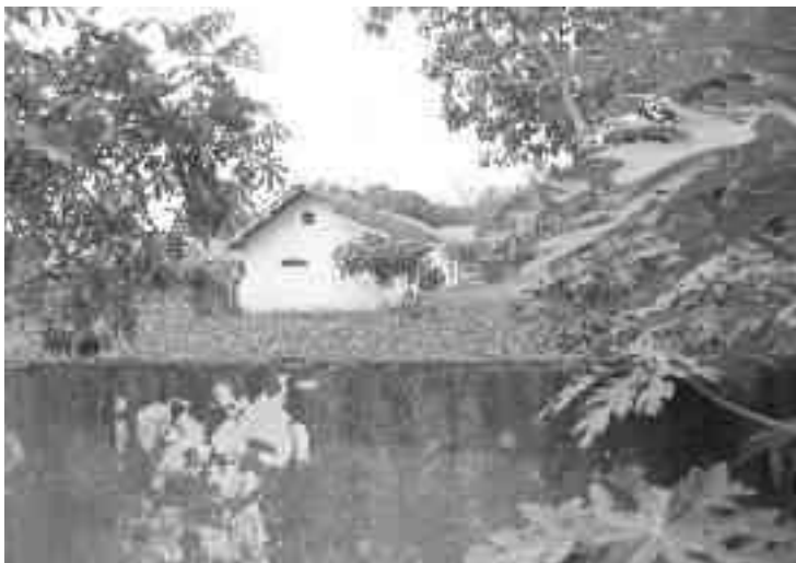
Sisa tembok pembatas gudang penyimpanan garam.
