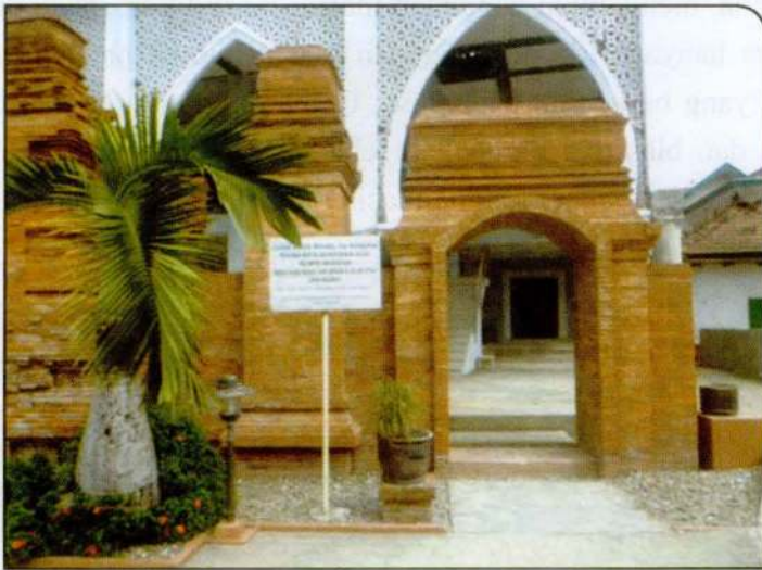
Foto 3. Gapura masjid bagian utara yang berbentuk Paduraksa
