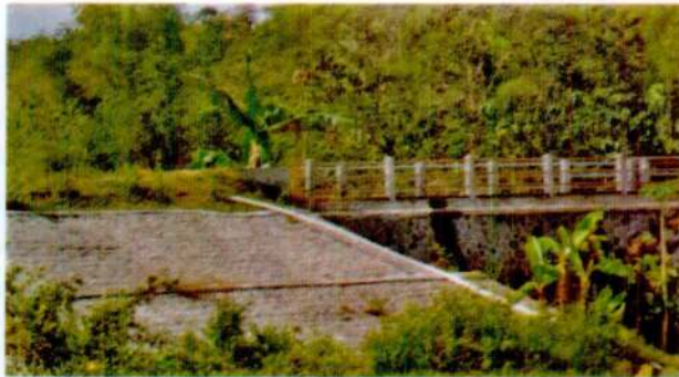
Foto 20. Pengambilan Air Dari Sungai Dengan Sistem Gravitasi.
