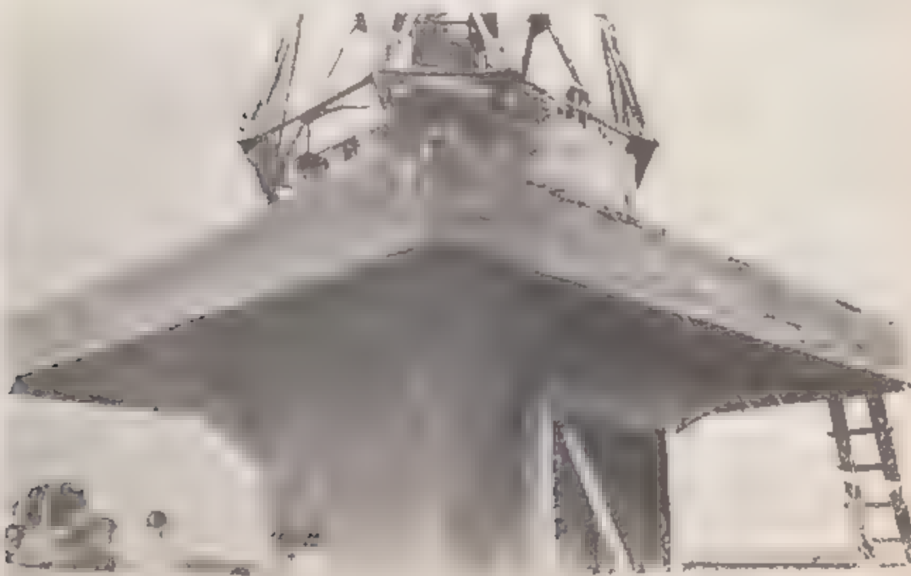
Selanjutnya, gambar menunjukkan kegiatan pemasangan pelataran puncak Tugu Nasional. Tampak pada gambar kegiatan pemasangan pelataran puncak Tugu Nasional. Kegiatan ini dilakukan di bagian puncak Tugu.
