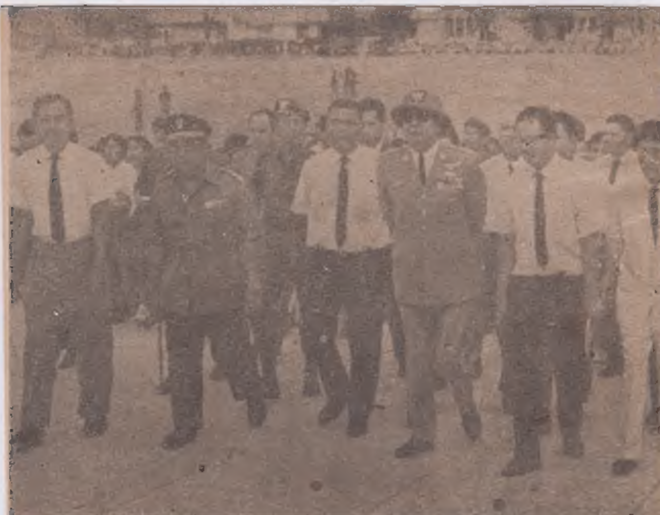
Baru ini mendjelang selesainya pekerjaan finishing touch Presiden Soekarno sendiri telah mengadakan peninjauan. Diantaranya didampingi Menteri PUT Major Djendral Suprajogi, Kepala Proyek Marmer Indonesia Murdani dan Gubernur DKI Jakarta Raja Dr Soemarno.
