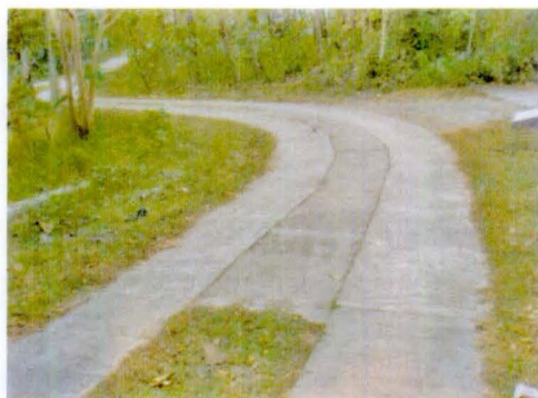
Foto 2. Jalan beton bantuan PNPM Mandiri Pedesaan
